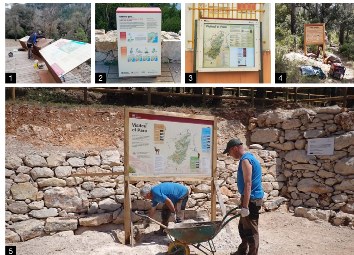
(1,2) Reposició de senyals malmeses al Mas de Quiquet i a Caro. (3) Substitució de la cartellera del Centre de visitants, a Roquetes. (4, 5) Instal·lació de senyals i cartellera a Valldebaus.
