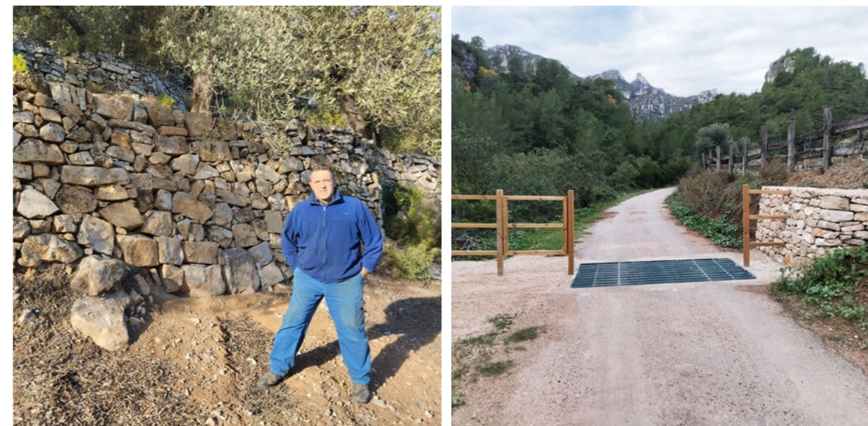
Reconstrucció de marges de pedra seca i instal·lació d'un pas canadenc fets mitjançant subvencions.
