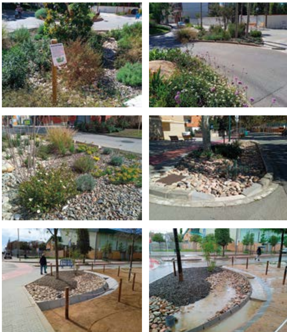
Fig. 52. Sis exemples de jardins de pluja. S'han fet llevant paviment impermeable. A la darrera imatge es pot veure el funcionament d'un d'aquests. Imatges cedides per Carles García i Paterna.
